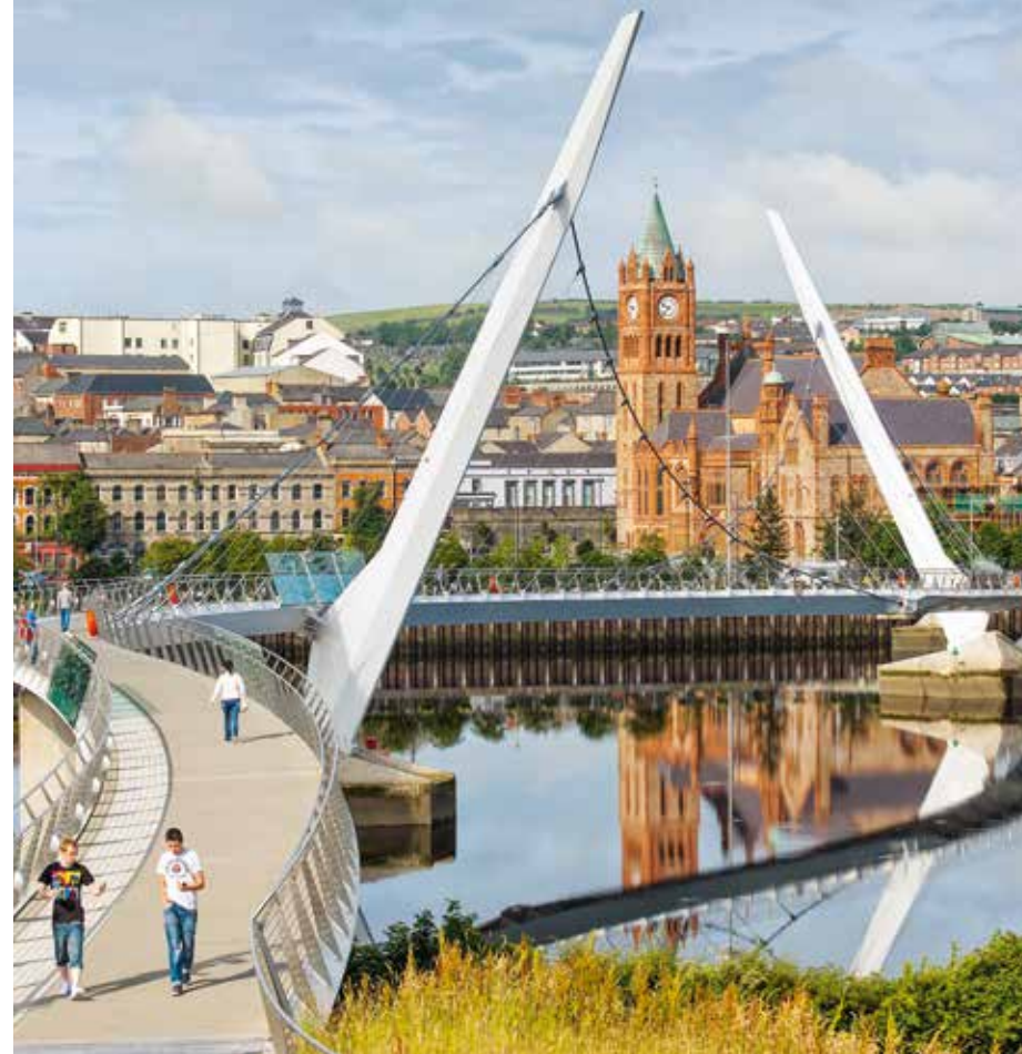
PEACE BRIDGE, DERRY-LONDONDERRY
